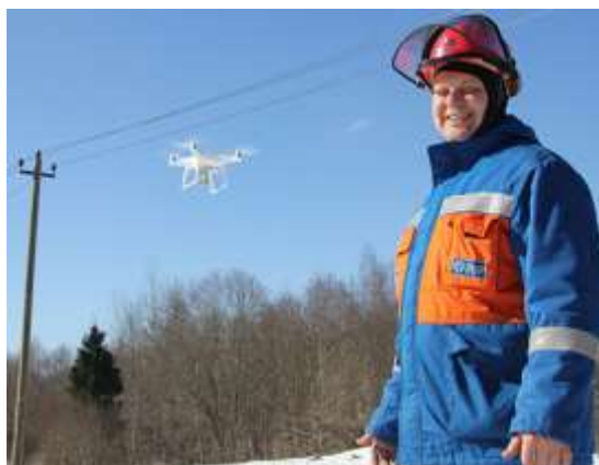
Рис. 1.- Осмотр воздушных линий при помощи квадрокоптера
