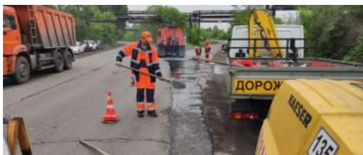
Рис. 1. - Ограждение места производства работ конусами
